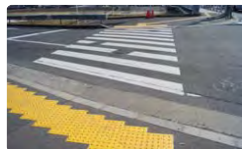
▲設置された点字ブロック
